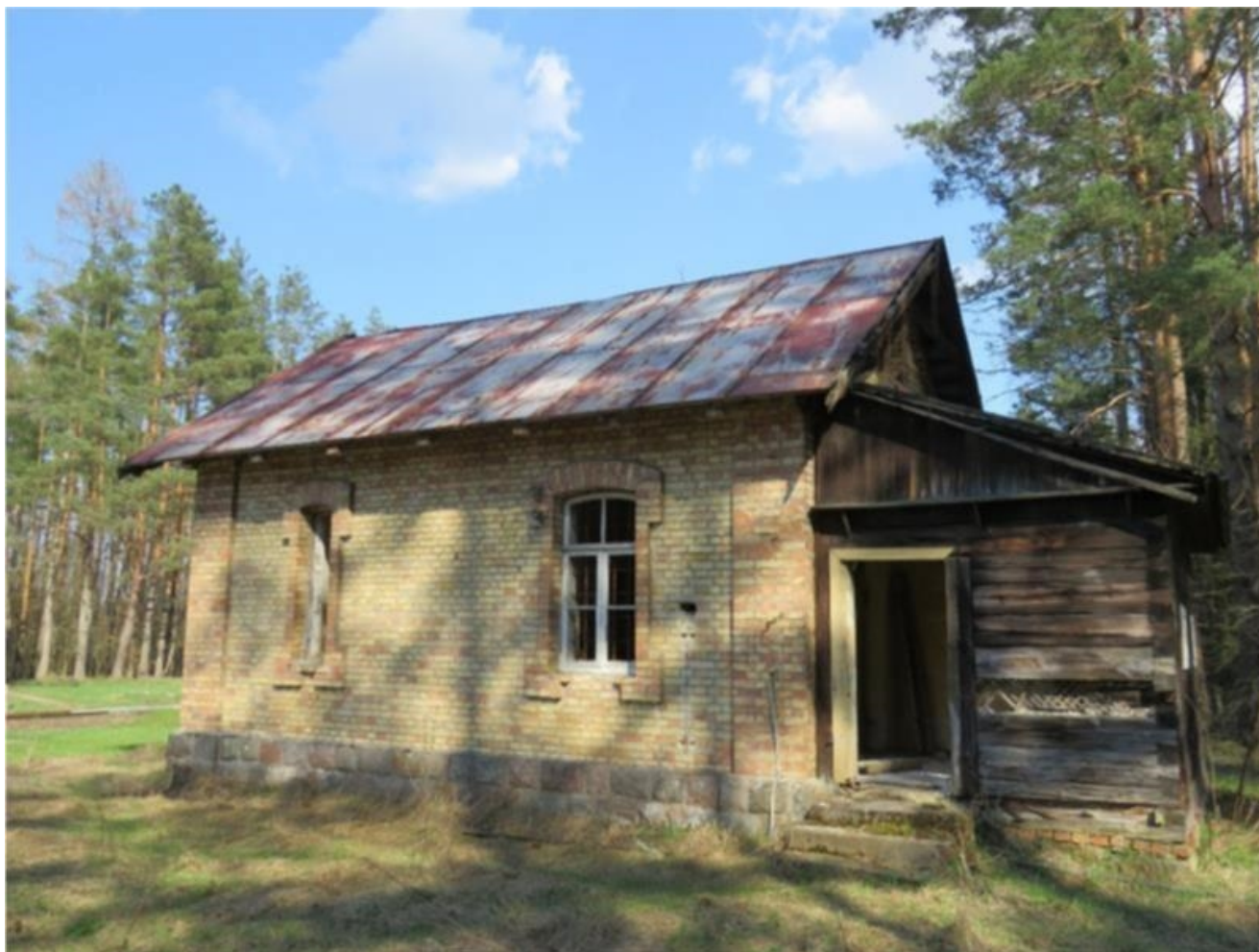
Zajezierce, budynek przystanku kolejowego
