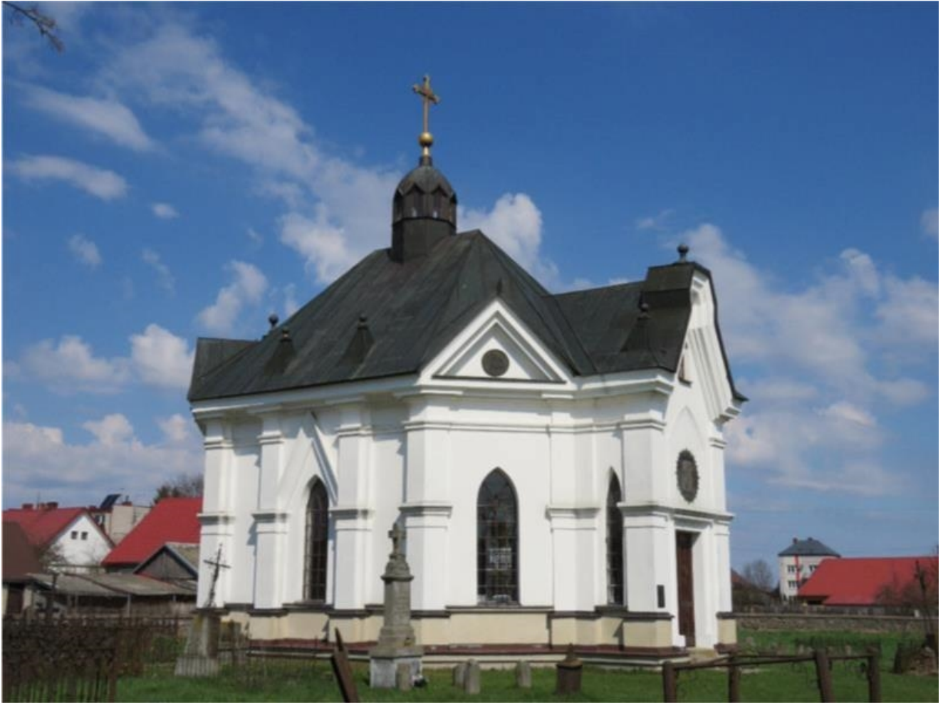
Zabłudów, kaplica cmentarna pw. św. Rocha
