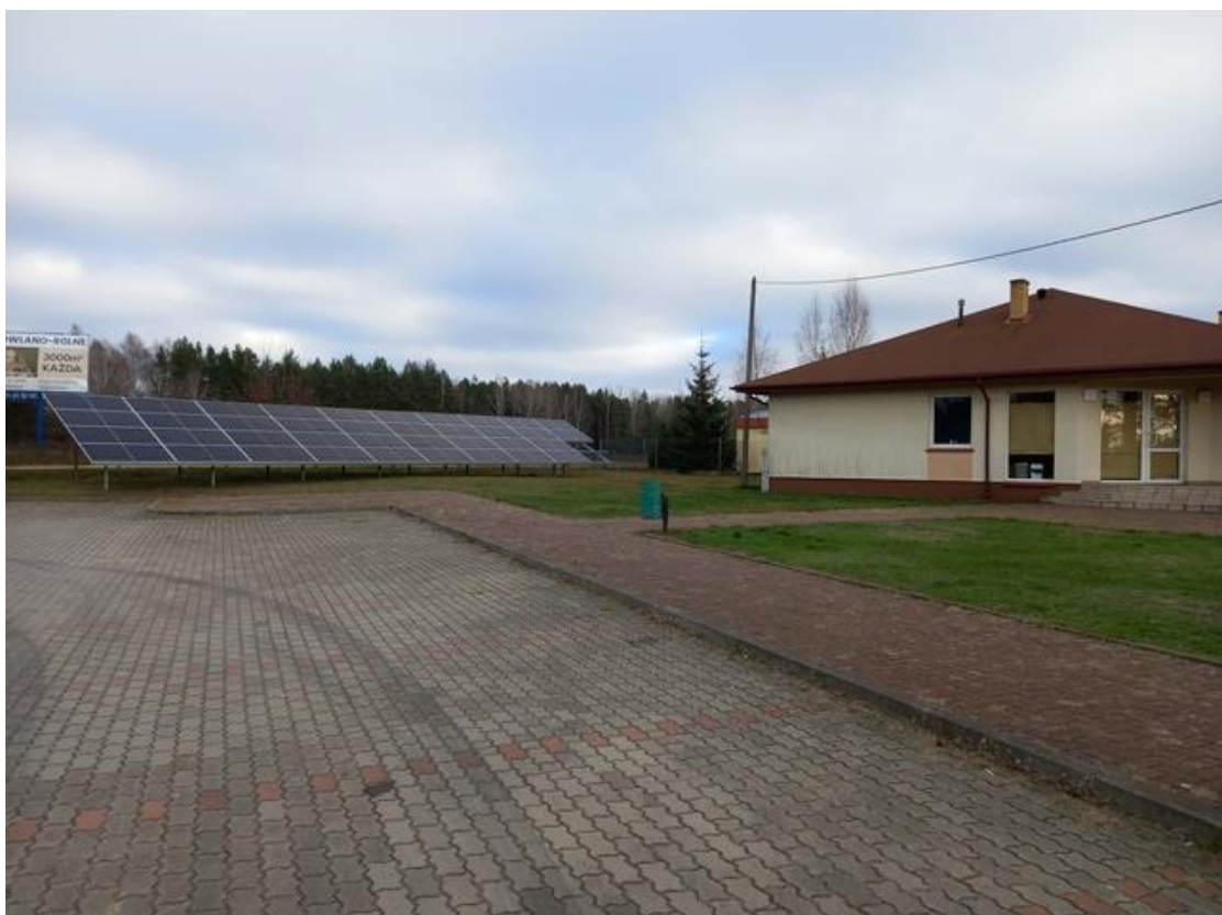
Budynek socjalny przy boisku sportowym w Zarzeczanach
