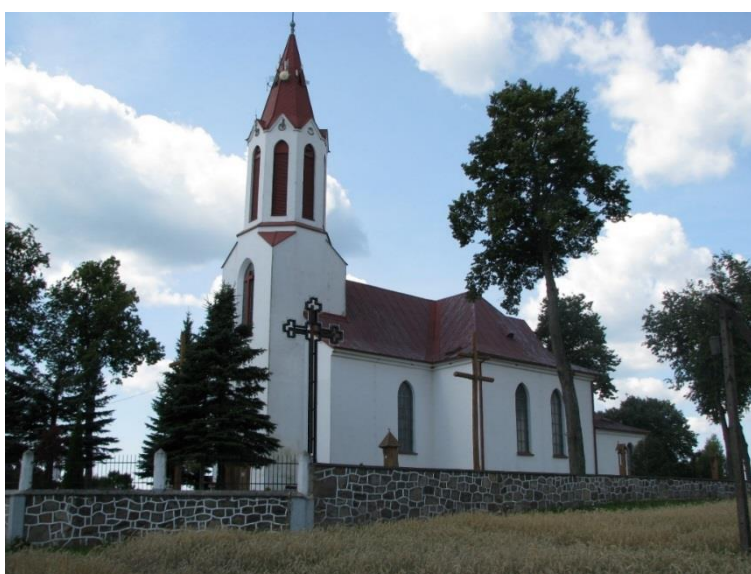
Ryc. 24. Kościół parafialny pw. Najświętszego Serca Jezusa w Starej Rozedrance (fot. J. Dąbrowski)
